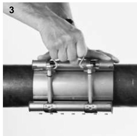
Verschluss einhaken. Schrauben abwechselnd und gleichmäßig anziehen.
