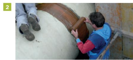
3. Намотайте полиэтиленовую ленту на защитную полоску для механической защиты. Перекройте полоску на 100 мм с обеих сторон.
