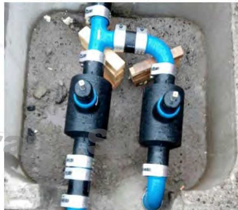
Временная система отвода грунтовых вод Германия
